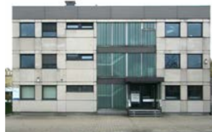
Das Gebäude vor der Sanierung
