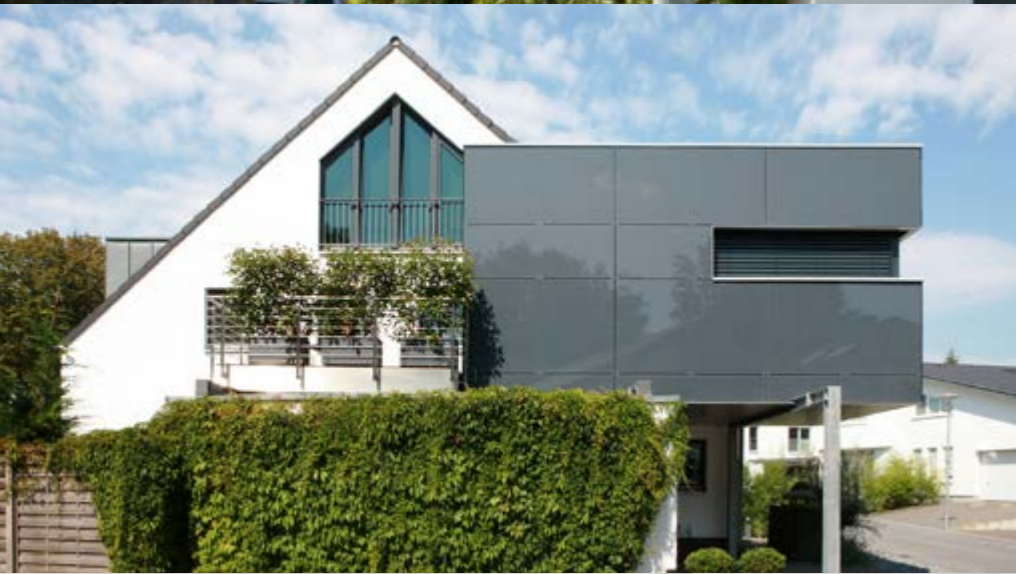
Erweiterung Einfamilienhaus. Angesetzter Kubus in futuristischer Anmutung.
