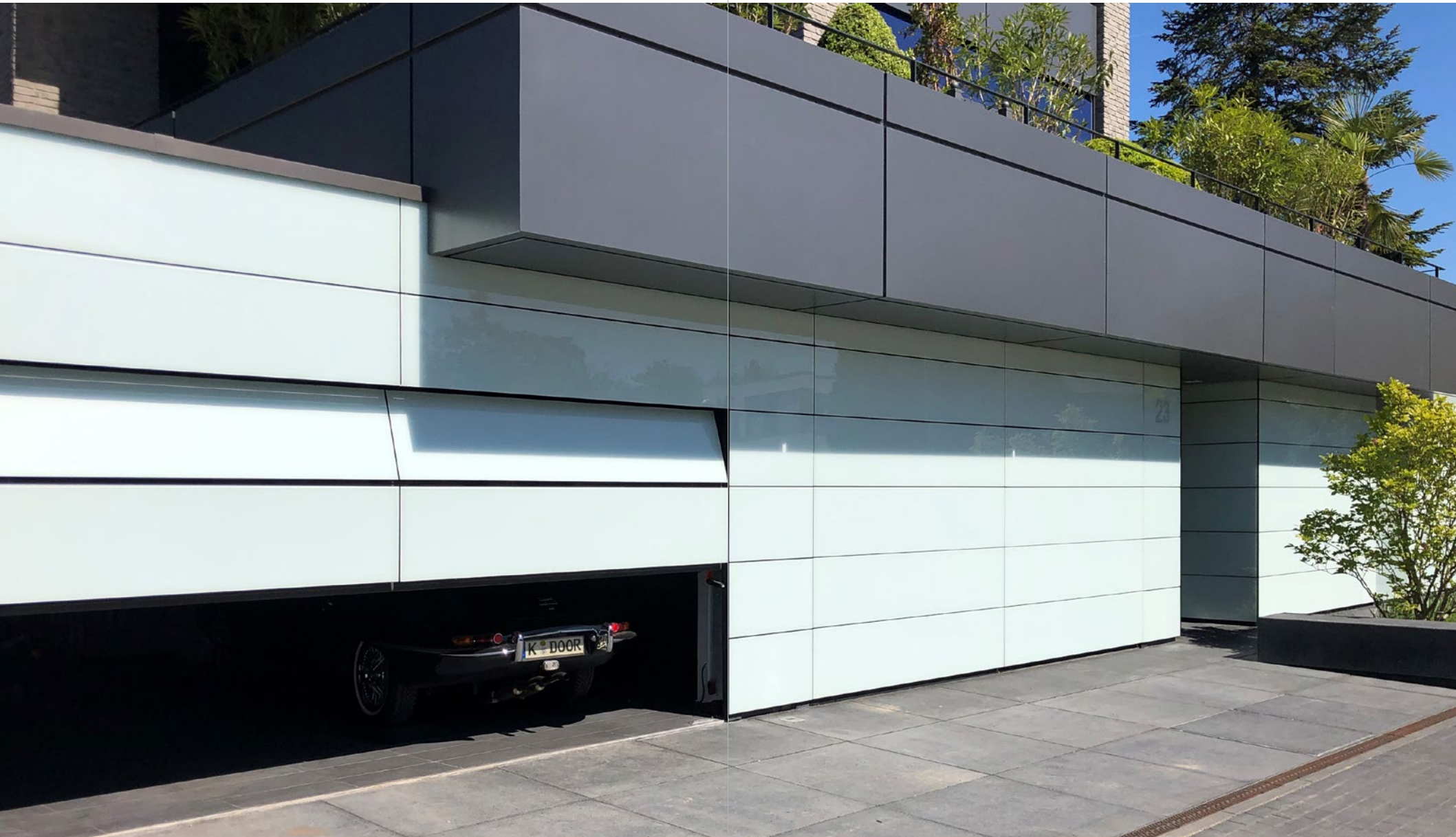
Projekt Meer-23 | Glasfassade mit flächenbündigem Garagentor
